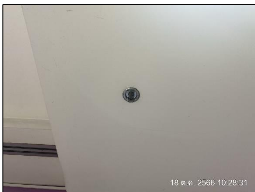
ภาพที่ 18 หัวกระจายน้ำดับเพลิง
