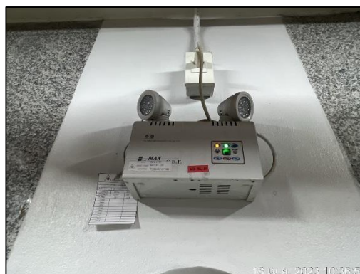
ภาพที่ 19 ไฟฟ้าสำรองฉุกเฉิน
